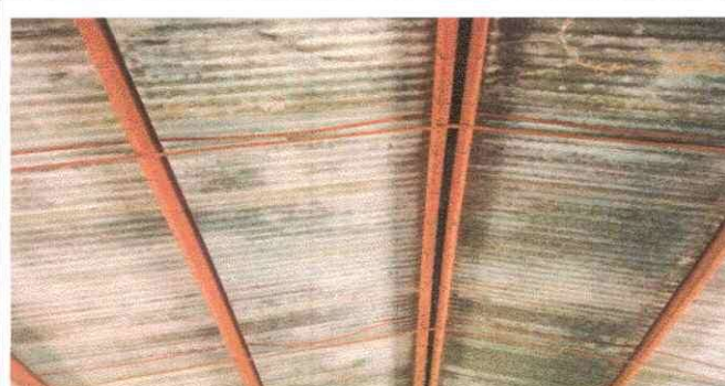
Foto 2: Se observa el deterioro de las costaneras de la escuela.
