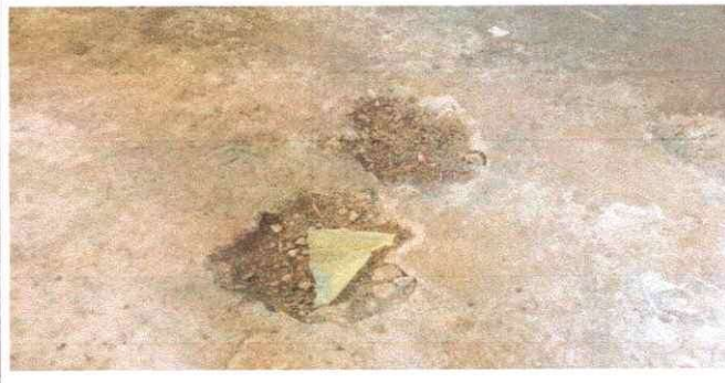
Foto 6: Se observa el deterioro del piso de la cocina de la escuela.
