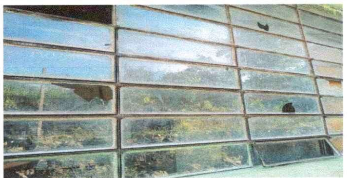
Foto 5: Se observa el deterioro de los vidrios de las venatanas de la escuela.
